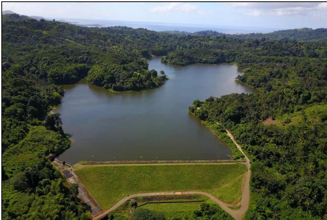
Document 4 : La retenue collinaire de Combani _ source: http://dronemayotte.fr
